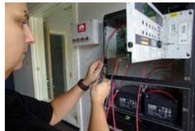
Hanna Johansson kopplar brandlarmscentralen.
